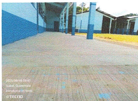
Foto 1: Piso de concreto sustituido.
