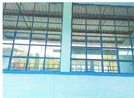
Foto 2: Mantenimiento de ventanas y colocacion de vidrios nuevos
