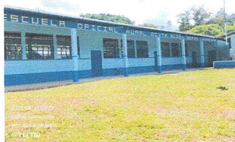
Foto: Vista panoramica escuela remozada.
