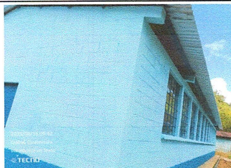
Foto 4: Vista posterior de aulas con pintura nueva.
